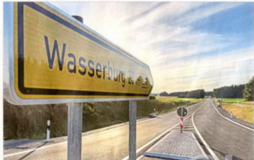
Drei Jahre lang haben die Bauarbeiten an der neuen Ortsumgebung gedauert. Nun sind die Arbeiten so gut wie abgeschlossen. Foto: Aicher
