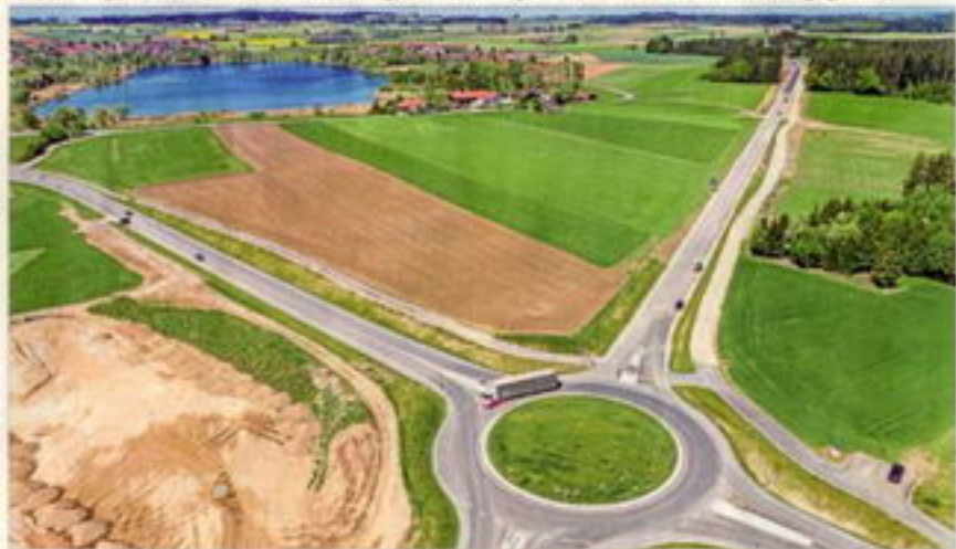
Der Kreisverkehr für die Umfahrung Obings im Osten des Ortes ist bereits fertig. In der kommenden Woche beginnen die Arbeiten westlich von Obing. Mitte Juli soll die Umfahrungsstrecke fertig sein. - Foto: Georg Unterhause/www.luftbild-traunstein.de
