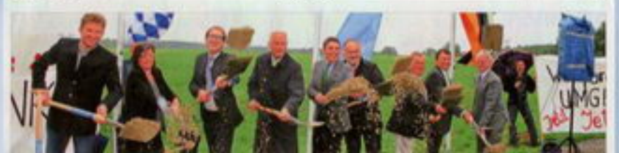
Bürgermeister Alexander Debratschke (links) und Obing-Ortsbürgermeister Peter Maltner (rechts) bei der Grundsteinlegung der Ortsumfahrung. Foto: Statistisches Bureau
