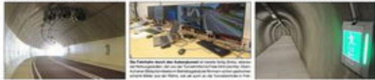
Die Aubergtunnel durch den Aubergtunnel ist bereits fertig, sodass der Verkehr wieder freigegeben werden kann.
