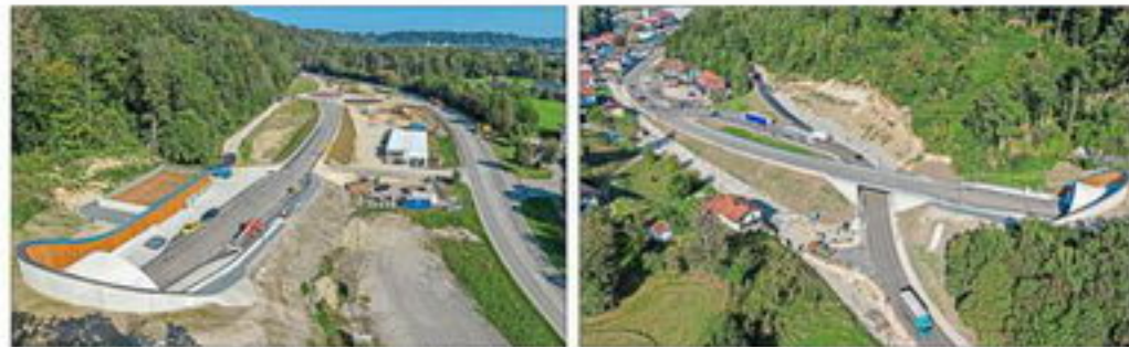
Am Nordportal des Aubergertunnels (links) werden über einen neuen Kreisverkehr die Altenerstraße (Ordnungshöhe) und die bestehende B 299 in Richtung Traunberg-Wichtung angefahren. Bis Mitte Oktober ist die Bundesstraße in diesem Bereich gesperrt, danach den Tunnel selbst kann man erst zum Jahresende frei fahren. Im Gegenzug wurde geplant die B 304 am Westportal des Tunnels (rechts) wieder für den Verkehr freigegeben. Im Bild sind mehrere Lastwagen auf der Ausfahrtrasse, die unter der Tunneloberfläche hin zum Ortszentrum beim „Schwarzwasser“ und weiter in Richtung Traunstein fah.
