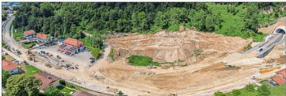
Die Bauarbeiten am Autobahneinbau in Altenmarkt schreiten voran. Die Erde des Jahres auf den Großbaustellen liegt nun. Aufwändiger als ursprünglich geplant gestaltet sich die Arbeit an der Variante des Tunnel-Drains. Die neue Variante ist ein weiterer Baustein der insgesamt 1,7 km langen Tunnel- und Umlenkung.
