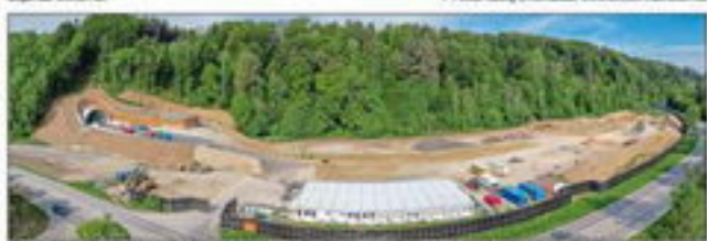
Im Norden des Tunnels wird derzeit der Baubereich für die neue Straßensperre, den Zugang zum Portal und einen Kreisverkehr geplant.
